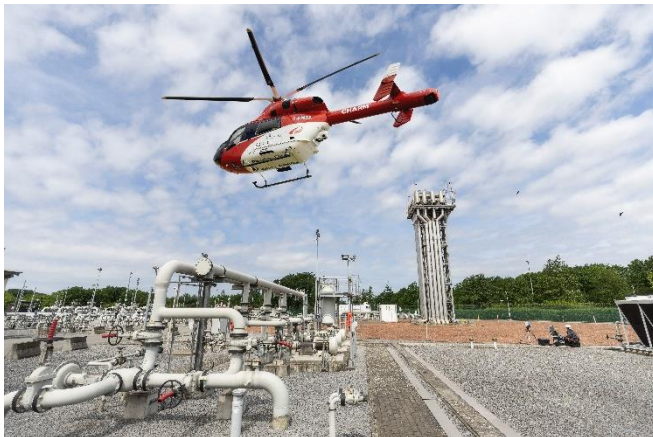
Bild 1: Der Helikopter mit dem LIDAR-System flog schon mehrere 10.000 km und prüfte Leitungen auf Lecks. © Fluxys, Avenue des Arts 31, B-1040 Brussels / Photo Fluxys Belgium - David Samyn.
